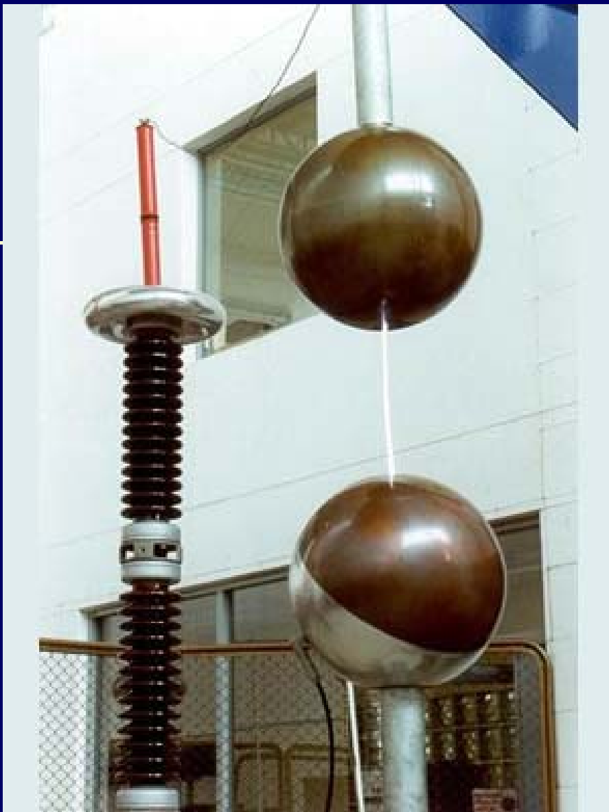
Equipo de alta tensión realizando la prueba de disrupción dieléctrica del aire
