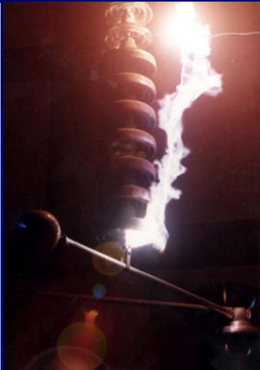
Cadena de aisladores de porcelana en pleno proceso de disrupción dieléctrica
