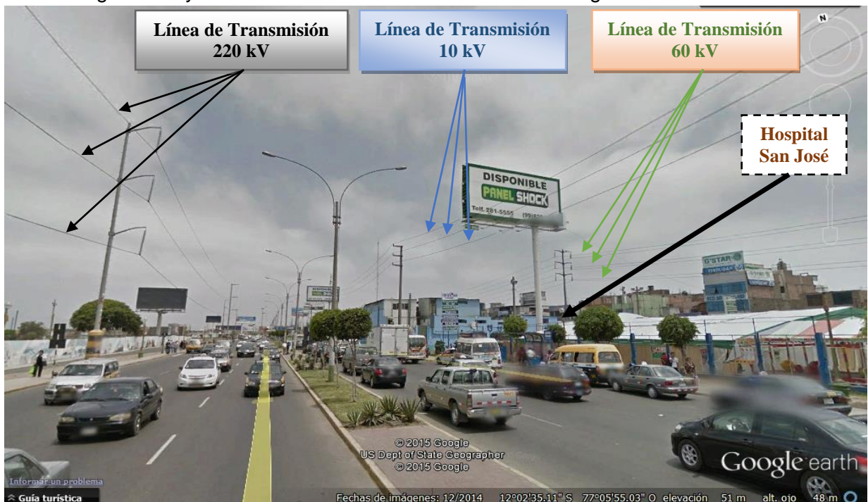
Figura N° 1 Líneas de Transmisión cerca a la Av. Elmer Faucett cruce con Morales Duarez
